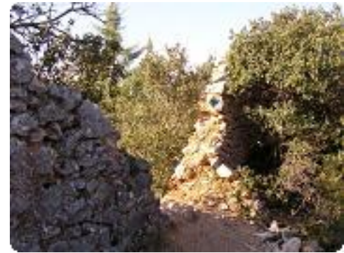
[9] Passage au travers de la muraille.
