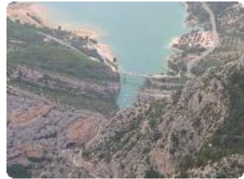
[21] Le pont de Galetas.
